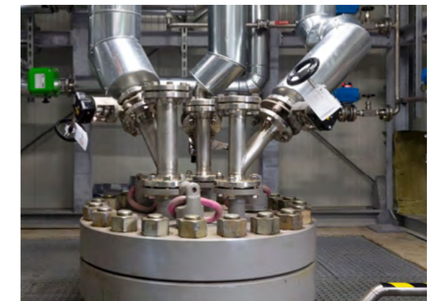
Abbildung 31: Injektionsbohrung Geothermie (Quelle: PIZ IUD)
